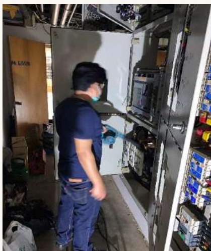
ทำการตรวจเช็คความเรียบร้อยภายในตู้ และวัดค่าความต้านทานของฉนวน MEGGER OHMS
