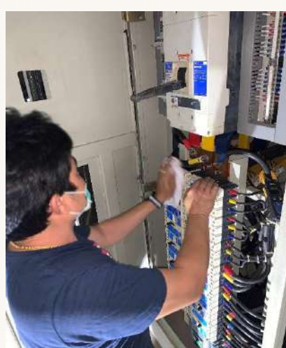
ทำความสะอาดภายในตู้ MDB และช่อง CAP.
