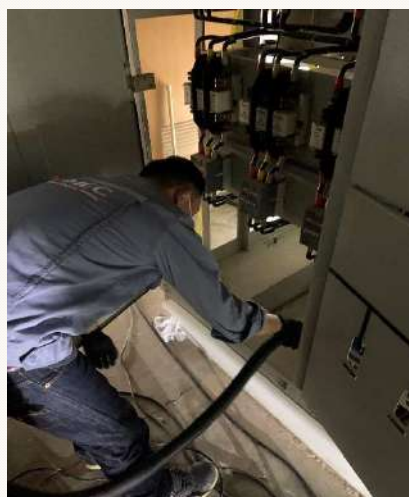
ทำการตรวจเช็คความเรียบร้อยภายในตู้ และวัดค่าความต้านทานของฉนวน MEGGER OHMS
