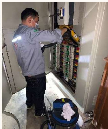
ทำความสะอาดภายในตู้ MDB และช่อง CAP.
